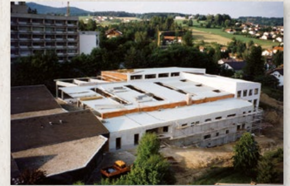
Erweiterung der Regener Werkstätten, Osserstraße
