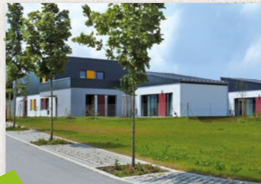
Bau Förderstätte mit TENE Osterhofen
