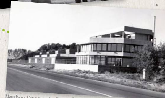
Neubau Deggendorfer Werkstätten, Max-Peinkofer-Straße
