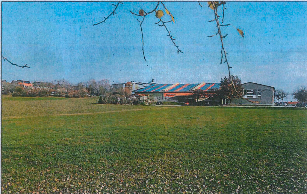
Noch grüne Wiese, aber in der Nachbarschaft zur Fitness-Oase an der Osserstraße sollen ein Hotel und der erweiterte Wellness-Bereich der Fitness-Oase entstehen.
